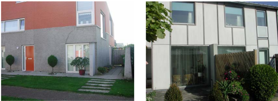
Figuur 3.3: Voor- en achtergevel van een kangoeroewoning in Nijmegen
