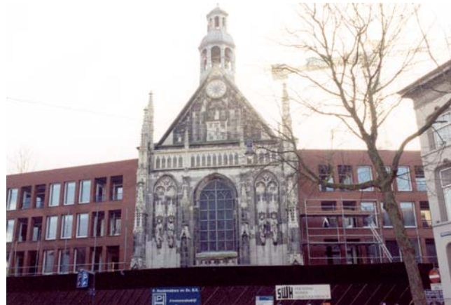
De gotische façade van de Antoniekerk is opgenomen in de nieuwbouw
