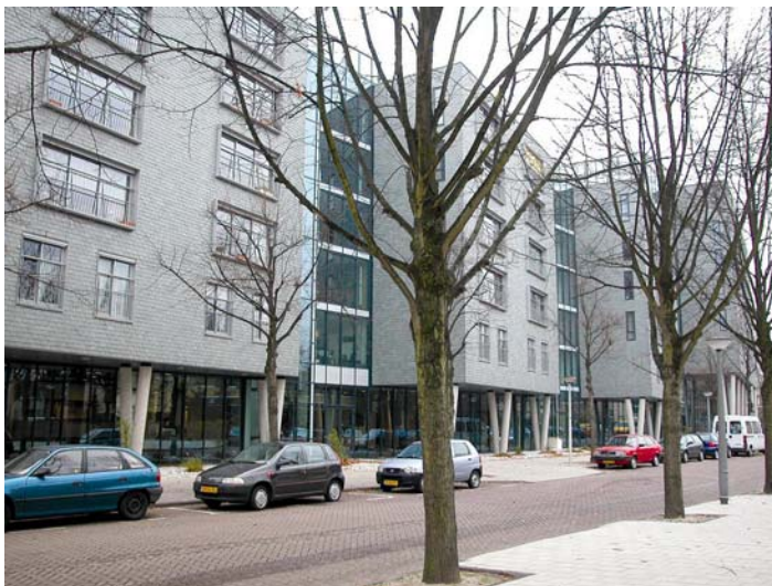
Torendael bestaat uit vier torens die geschakeld zijn met glazen corridors
