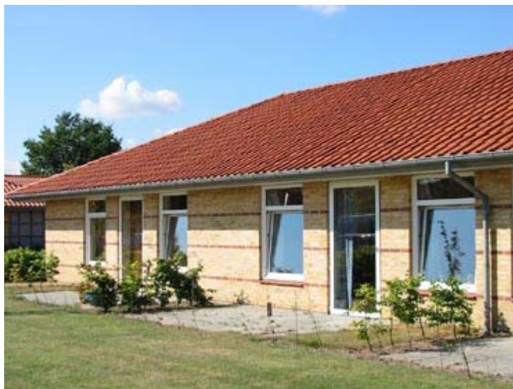
Figuur 3; zorgappartementen bij Havkaer
