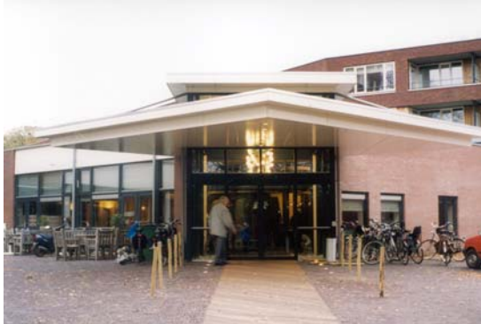
foto 1 De hoofdentree tot Skewiel Trynwâlden. Links het restaurant en op de achtergrond de nieuwe appartementen.
